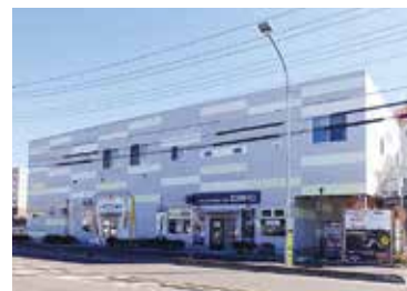
埼玉県戸田市に所有するテナントビルにも日本テクノのサービスを採用。
