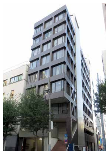
地上9階・地下1階。オフィスを中心に14テナントが入居。
