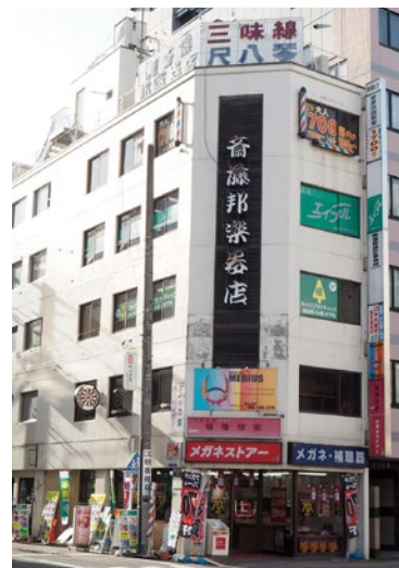
斎藤邦楽器店ビルの外観。5階建てのビルには、飲食店やショップ、オフィスなどが入居する。
