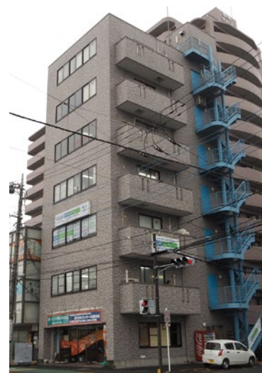
店舗やオフィスが入居する7階建てのテナントビル「三幸中央ビル」。エコテナントを最初に導入した物件。その後、適応する高圧受電の物件すべてに採用している。
